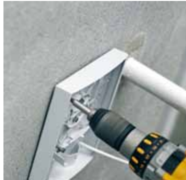
Teknikeren sætter den udvendige fiberboks op og borer hul gennem muren.
